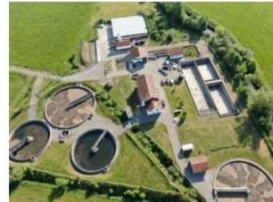
Verbandskläranlage in Altenstadt
